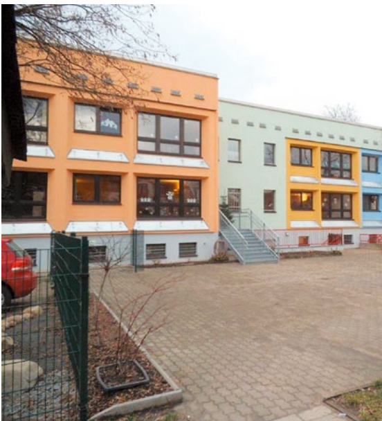
Sanierte Außenfassade der Kita „Tausendfüßler“
