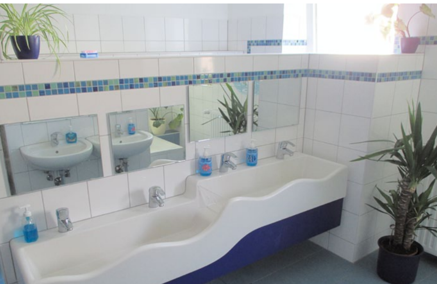
Renoviertes Bad in der Kita „Naseweis“
